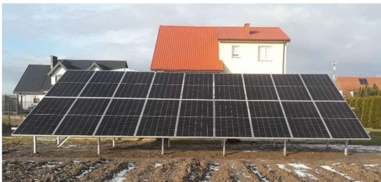
rys. 5 Środowisko instalacyjne – Konstrukcja gruntowa
