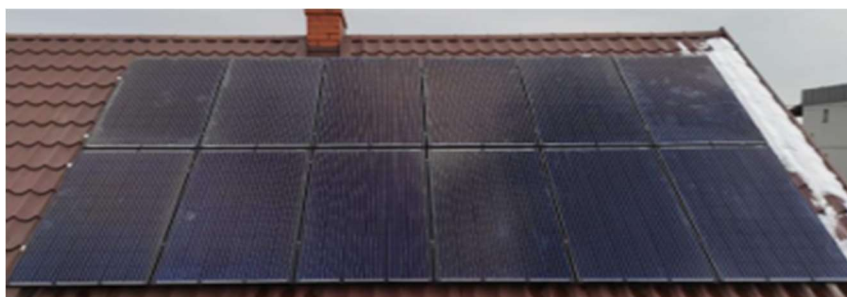
rys. 3 Zdjęcia wykonane w pochmurny dzień. Różnice wizualne spowodowane zabrudzeniem oraz wilgocią.
