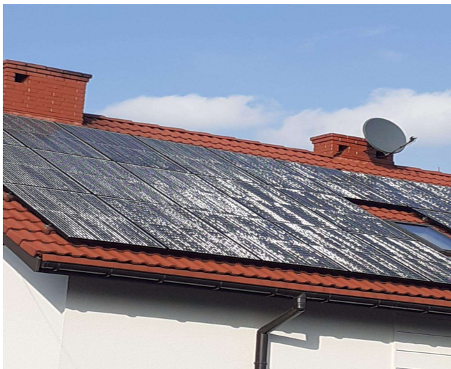
rys.1 Efekt LRF w słoneczny dzień
