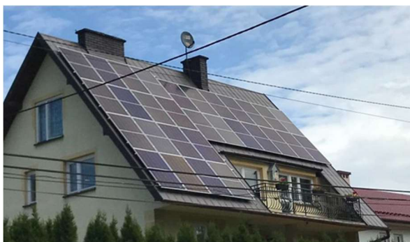
rys.1 Wymieszane moduły z 3 palet o różnych kategoriach kolorystycznych
