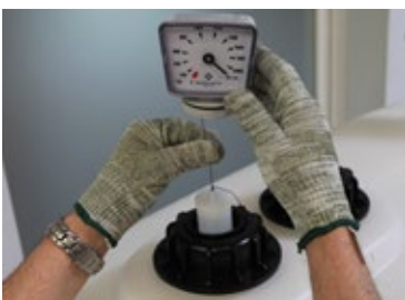
Etap 28: Powoli wsunąć obciążnik mechanicznego wskaźnika poziomu oleju do bezpiecznego zbiornika na olej opałowy. Dokręcić mechaniczny wskaźnik poziomu oleju w nakrętce.
