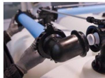
Etap 6: Kolanko zwrotne 12 wraz z rurą rozbudowującą przymocować do elementów rozbudowujących za pomocą obejm i śrub.
