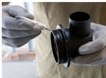
Etap 13: Lekko natłuszczyć 6 smarem pierścienia samoszczelniającego o przekroju okrągłym na kolanku odpowietrzającym \varnothing 70\text{mm} 8
