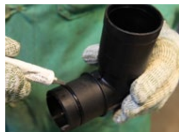
Etap 6: Lekko natłuszczyć 6 smarem pierścień samuszczelniający o przekroju okrągłym na kolanku odpowietrzającym \varnothing 42\text{mm} 7
