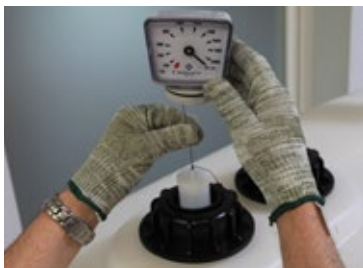
Etap 23: Powoli wsunąć obciążnik mechanicznego wskaźnika poziomu do bezpiecznego zbiornika na olej opałowy. Dokręcić mechaniczny wskaźnik poziomu oleju w nakrętce.
