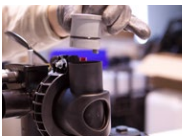
Etap 14: Wsunąć do oporu zatyczkę odpowietrzającą \varnothing 42\text{mm} 12 do kolanka odpowietrzającego \varnothing 42\text{mm} 7 lub \varnothing 70\text{mm} 8
