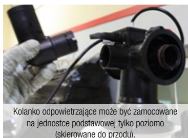
Etap 7: Zatrzęsnać kolanko odpowietrzające \varnothing 42\text{mm} 7 w jednostce podstawowej 1
