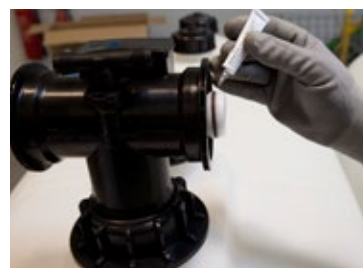
Etap 6: Lekko natłuszczyć 6 smarem pierścienia samoszczelniającego o przekroju okrągłym na elemencie rozbudowującym 14
