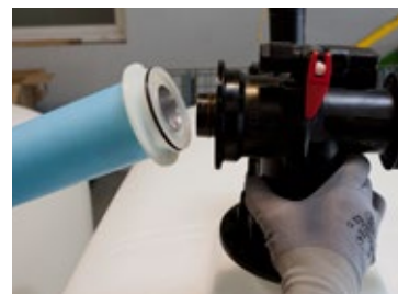
Etap 9: Włożyć do oporu rurę rozbudowującą 15 do jednostki podstawowej 1
