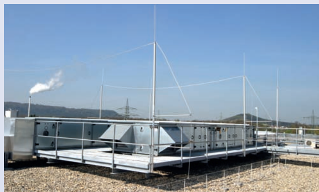
Rozpięte zwody izolowane DEHNiso-Combi
