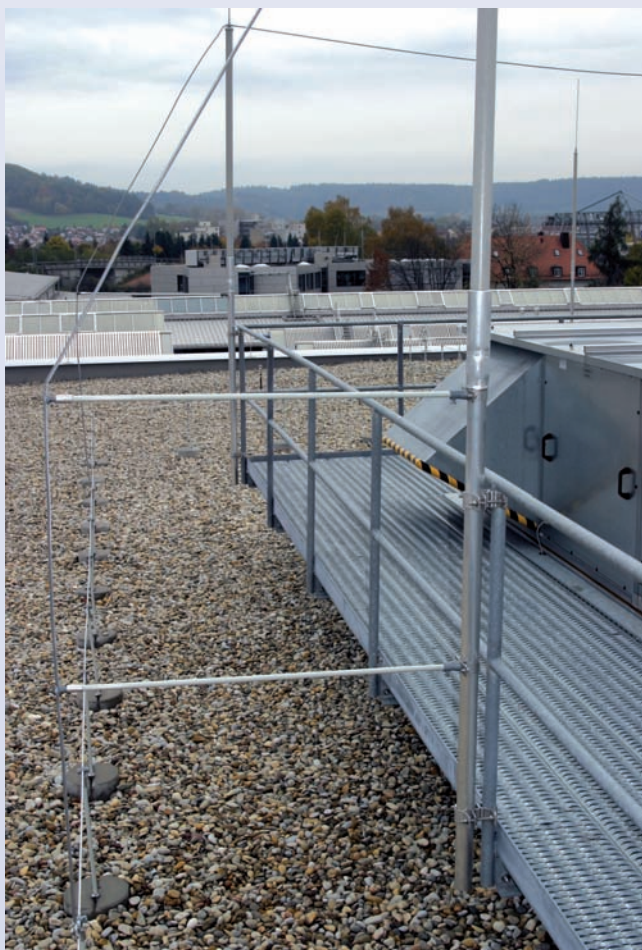
Wspornik dystansujący na rurze wsporczej
